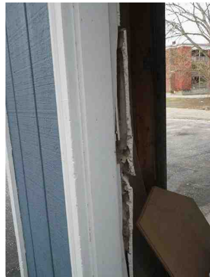
Broken door frame
